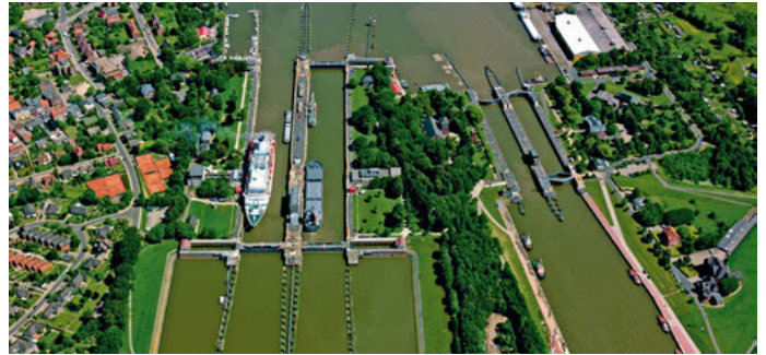
Bestehende Infrastruktur erhalten: Investitionsbedarf besteht z.B. an den Schleusenammern entlang des Nord-Ostsee-Kanals – wie hier in Brunsbüttel.
