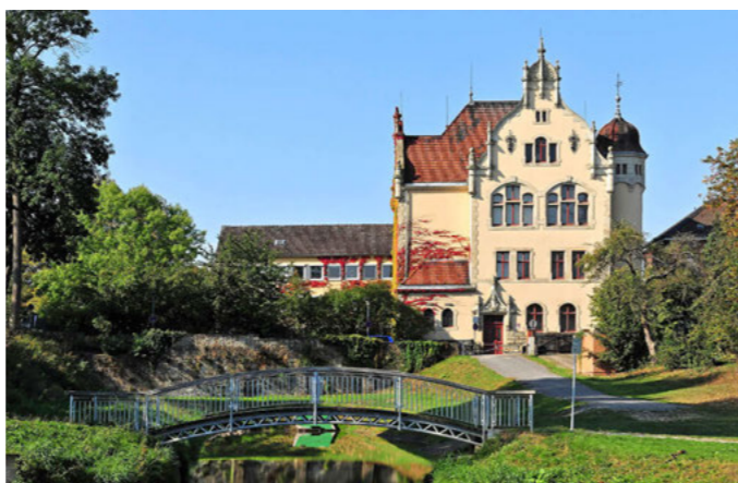
Sieht idyllisch aus, hat aber seine Tücken: Wie viele andere niedersächsische Gerichte ist auch das Amtsgericht Neustadt am Rübenberge in einer historischen Liegenschaft, in diesem Fall im Schloss Landestrost, untergebracht. Infolgedessen ist das Nebengebäude nicht barrierefrei – genauso wie 34 weitere Gerichtsgebäude in Niedersachsen.
